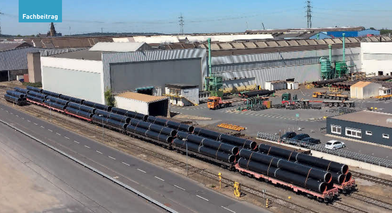
Das Röhrenwerk der Europipe GmbH in Mülheim an der Ruhr hat eine lange Tradition – auch im Arbeitsschutz.
